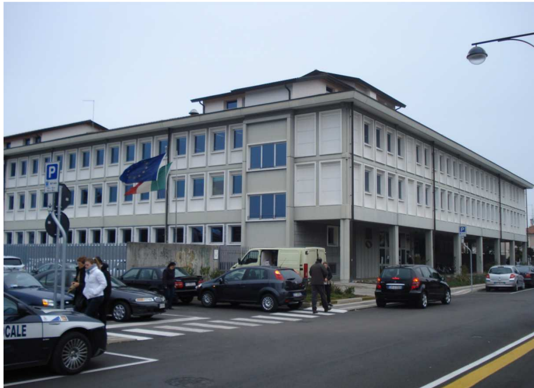
Fabbricato dell'Inps in via Trento
